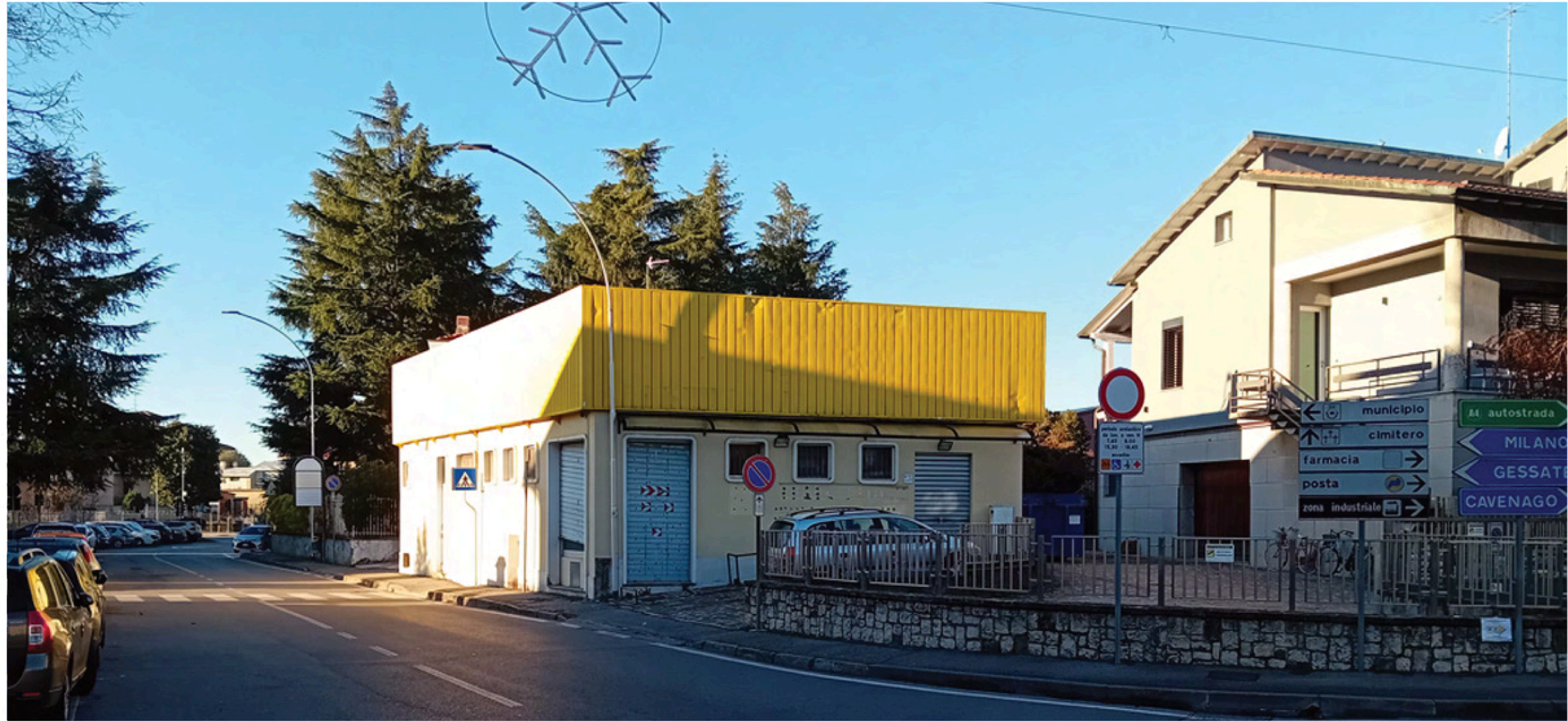
Fotografia Stato di fatto
